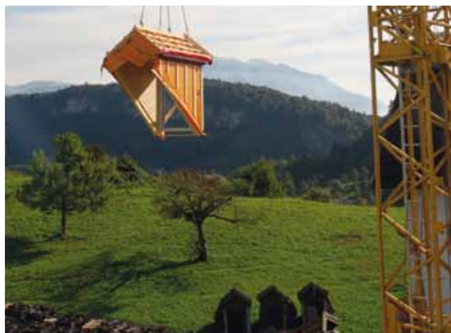
Dachsanieerung – Austausch der Gauben
