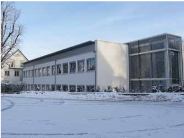
Neuer Anbau an das Krankenhaus Maria Ebene
